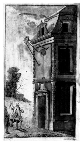
Une méridienne marque le moment du passage du soleil à midi au méridien du lieu. La méridienne était employée comme moyen de contrôle pour régler les horloges mécaniques. Une méridienne est constituée d'une graduation verticale et d'un disque décoratif percé, placé à l'extrémité d'une potence en forme de tripode, permettant de localiser précisément la position du soleil.
