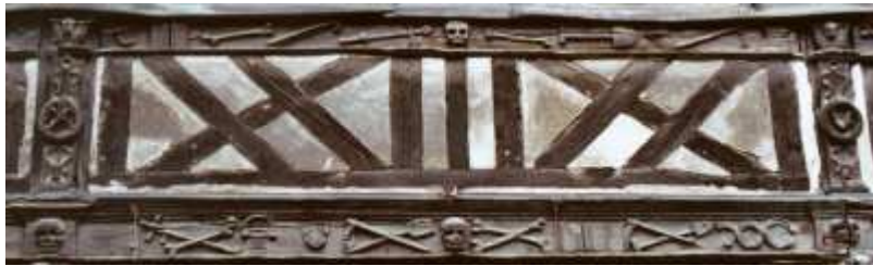
détail de colombage de l'Aître Saint Maclou
