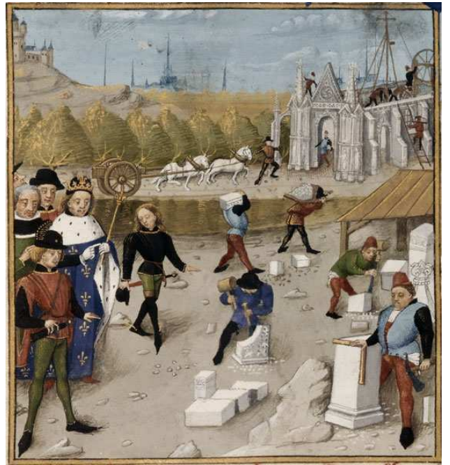
Dagobert visitant le chantier de la construction de Saint-Denis Robinet Testard, Poitiers, XV e siècle
